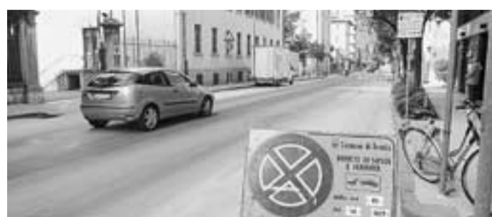
La sperimentazione dell'asfalto mangiasmog in via Perini
